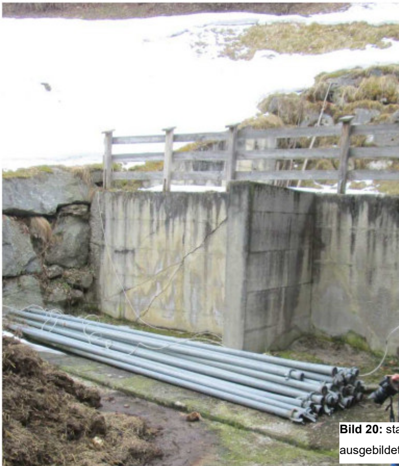
Bild 18: Risse in taleinw. liegender Außenwand
