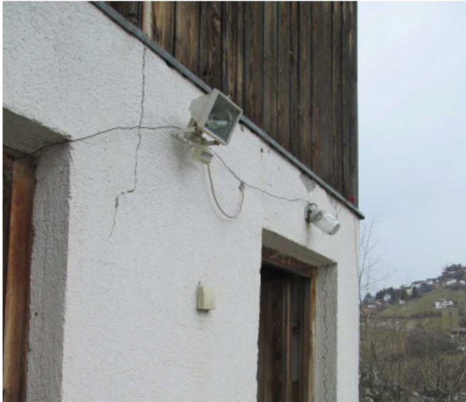
Bild 18: Risse in taleinw. liegender Außenwand
