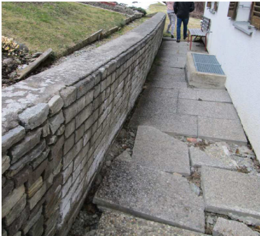
Bild 5: Eine Stützmauer im Garten (bergseitig) baucht aus und hängt sichtbar über.
