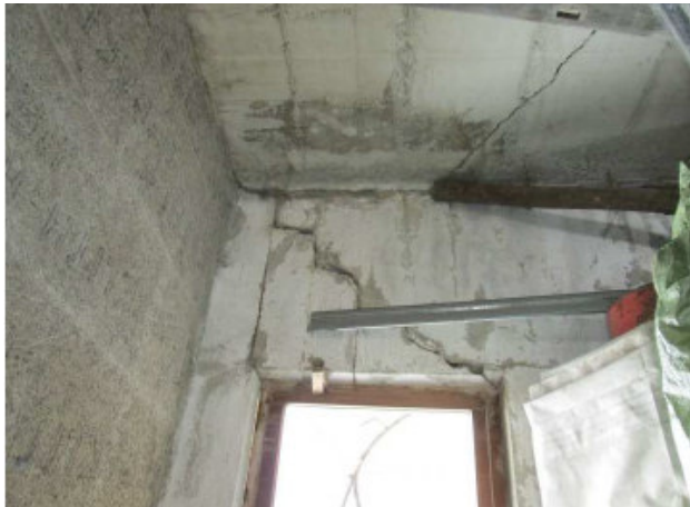
Bild 35: taleinwärts liegende Wand
